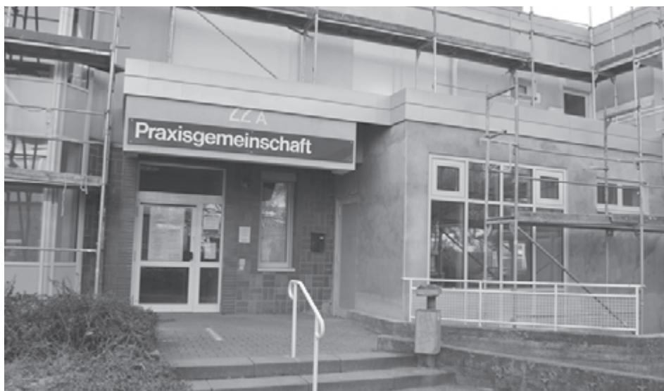
Noch stehen außen die Gerüste, aber innen wird alles fertig sein
