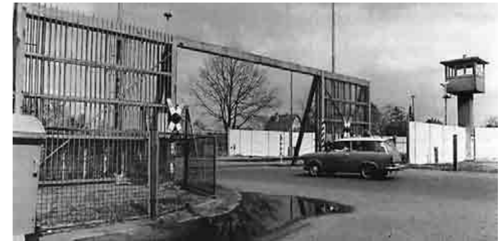
Der sogenannte Affenkäfig am Bahnübergang nahe dem Bahnhof West-Staaken
